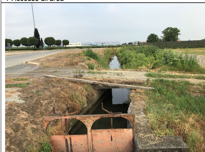
3-Vista della bealera intubata a sud dell'area
