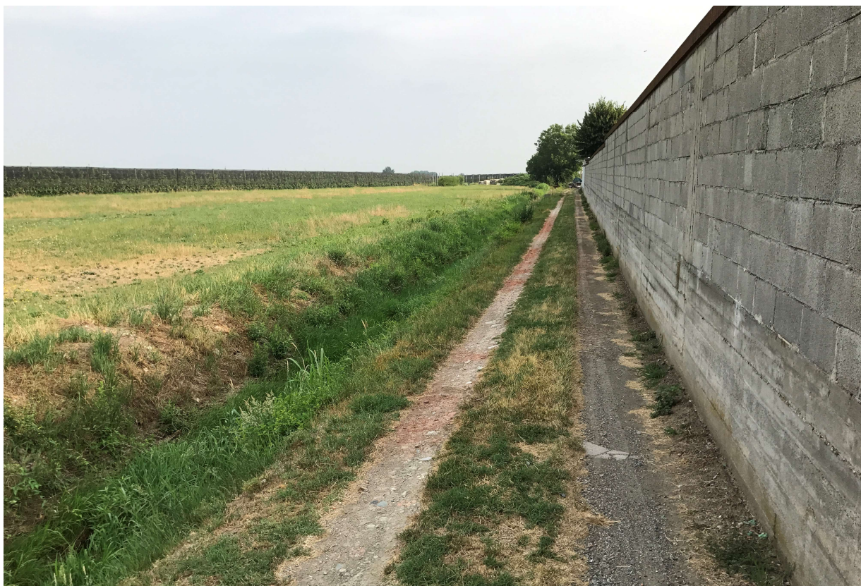
FOTO 6. VISTA DEL BEDALE A CONFINE VERSO EST
