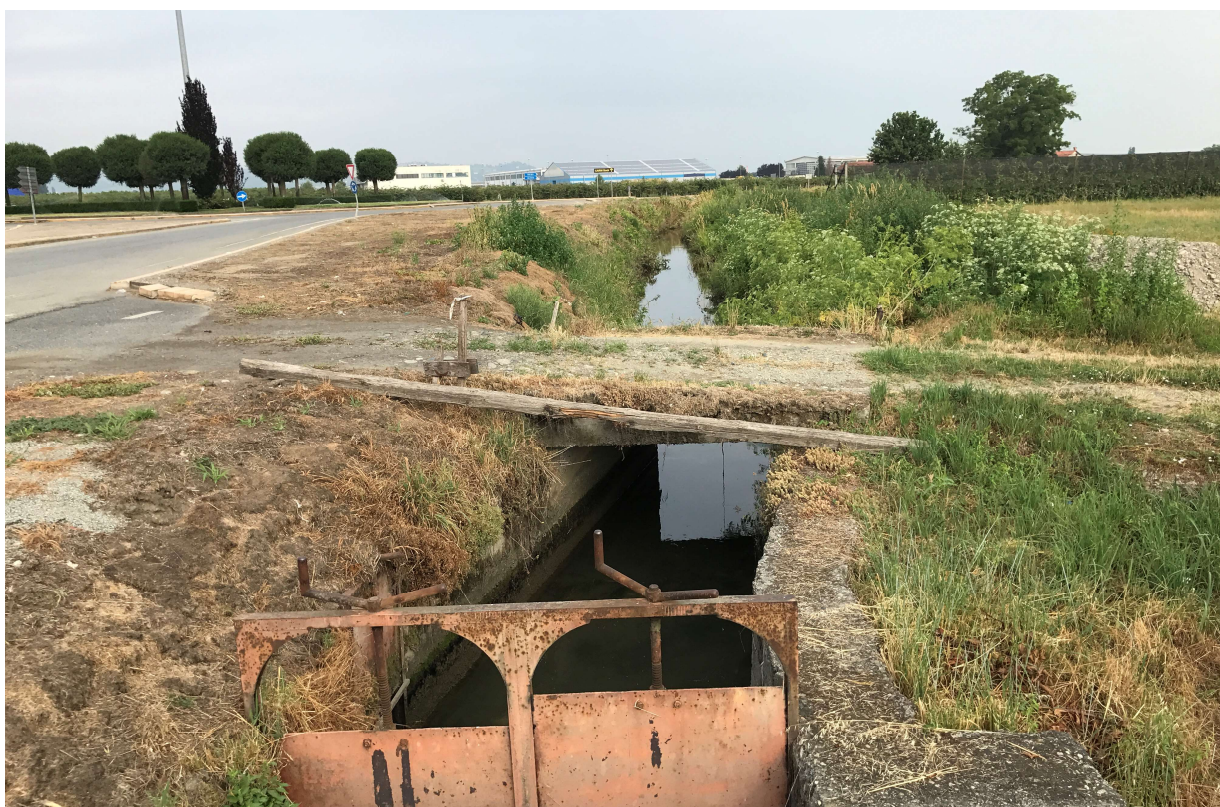
FOTO 5. VISTA DEL BEDALE DI SEPARAZIONE TRA IL LOTTO E LA VIA S.MARIA
