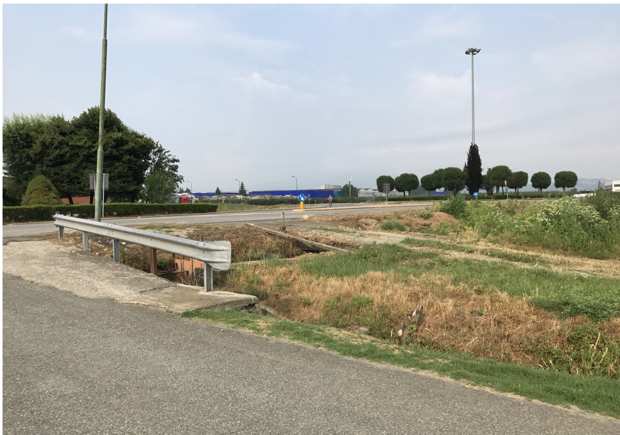
FOTO 4. VISTA DELLA VIA S.MARIA A CONFINE CON IL LOTTO
